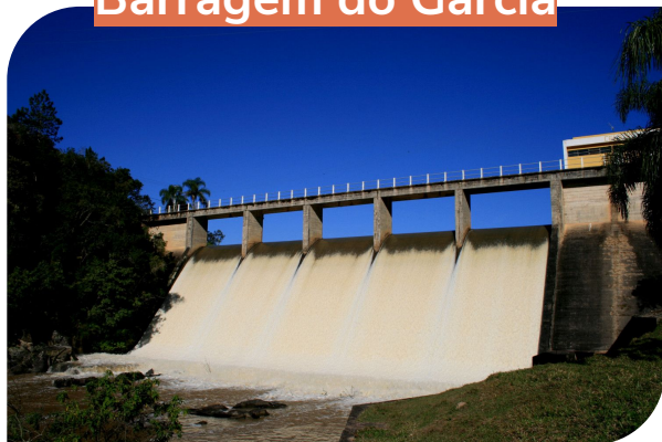
Barragem do Garcia
