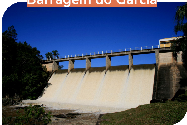
Barragem do Garcia
